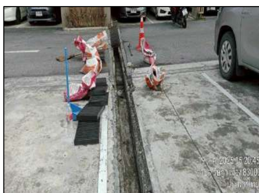
รูปภาพที่ 2.51 การขุดลอกตะกอน
