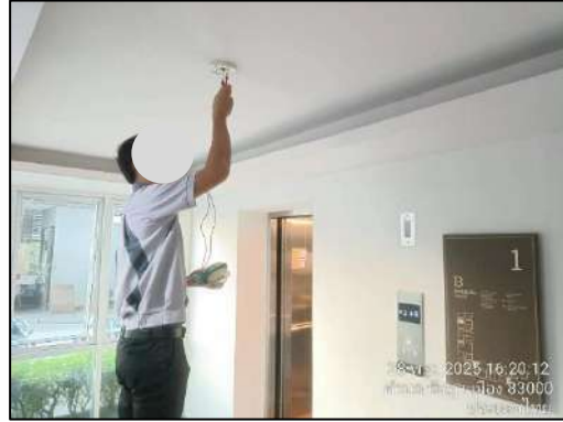
รูปภาพที่ 2.48 การตรวจสอบประสิทธิภาพของอุปกรณ์ป้องกันและแจ้งเตือนอัคคีภัย
