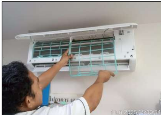
รูปภาพที่ 2.58 การทำความสะอาดเครื่องปรับอากาศ
