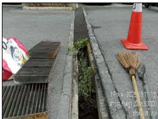
รูปภาพที่ 2.51 การขุดลอกตะกอน
